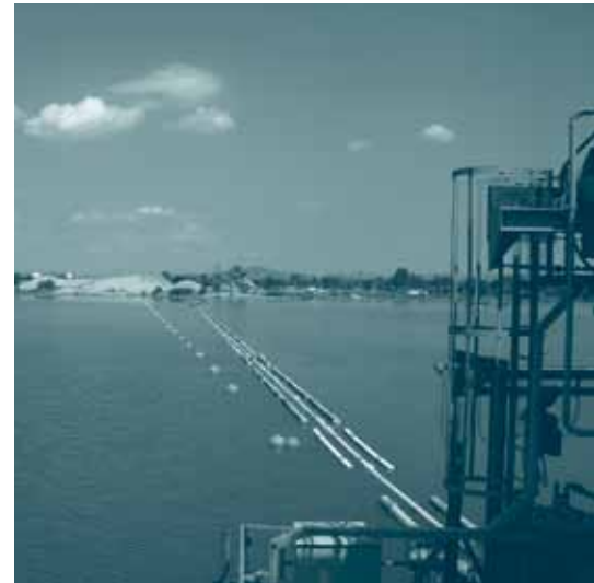
Zur Übermittlung von Schaltsignalen, ...
