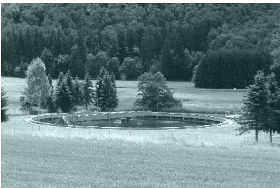
Ansteuerung von Pumpen, Bojen, ...
