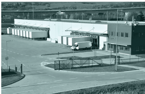
Toransteuerung mit Adressierung...
